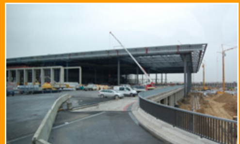
Noch fahren hier nur die Baufahrzeuge vor. Im Herbst 2011 sollen die Flughafengäste über diese Zufahrt zum Terminal gelangen.
